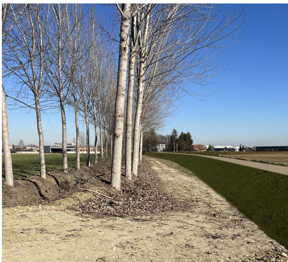
Figura 6: Stato di progetto tratto G – argine tipo 3 distanziamento di 4 m al piede del rilevato dal filare di pioppi esistenti, per la loro salvaguardia
